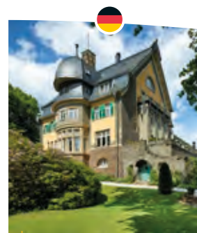
Villa Huesgen - Traben
